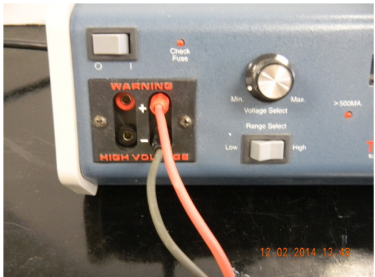
Figura 19. Electrodo de la cámara conectados a la fuente de poder
